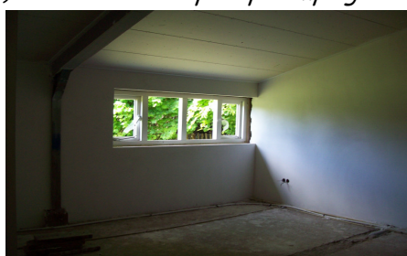
de 'Linde' kamer in aanbouw
