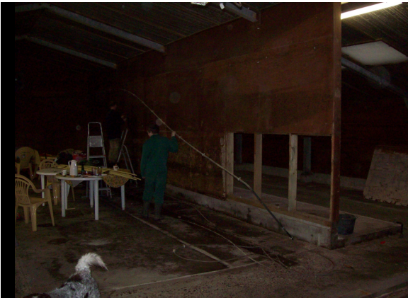
de tussenschotten worden weggehaald
