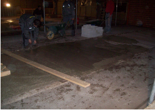
de melkput wordt dichtgemaakt
