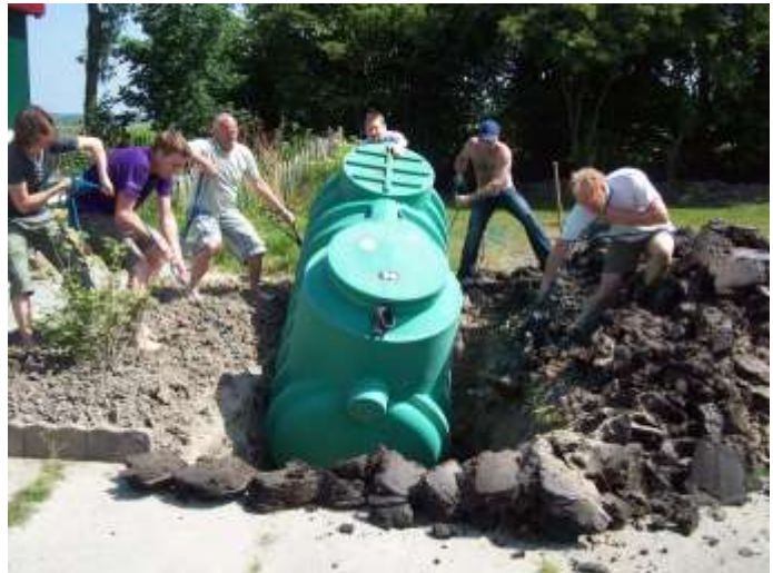
2011 plaatsen septictank voor camping
